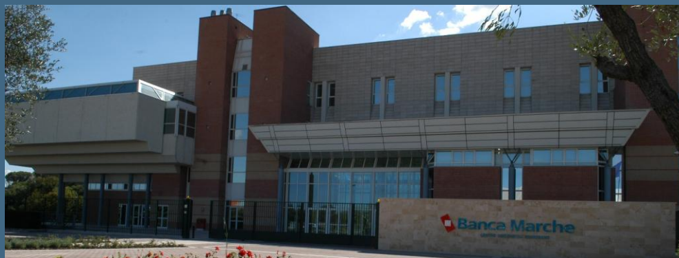
Sede Banca Marche • Centro Direzionale Fontedamo, Jesi (AN)
