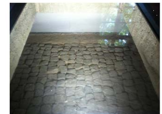
Pavimentazione con vespaio
